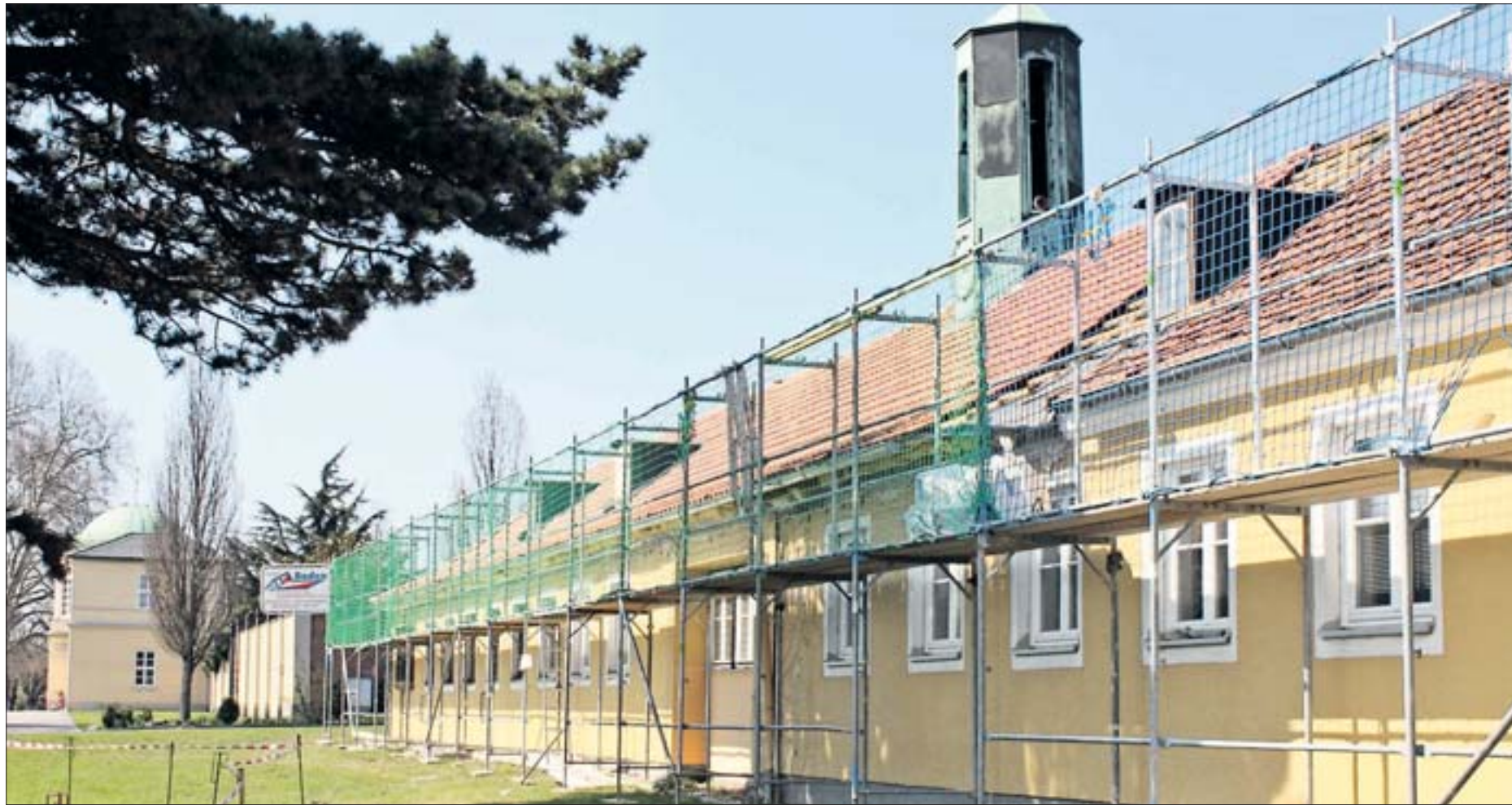
Die Räume an der Herrenhäuser Straße teilen sich ab Herbst Kinder und Angestellte der Universität. Im Hintergrund ist der Bibliothekspavillon zu sehen.
