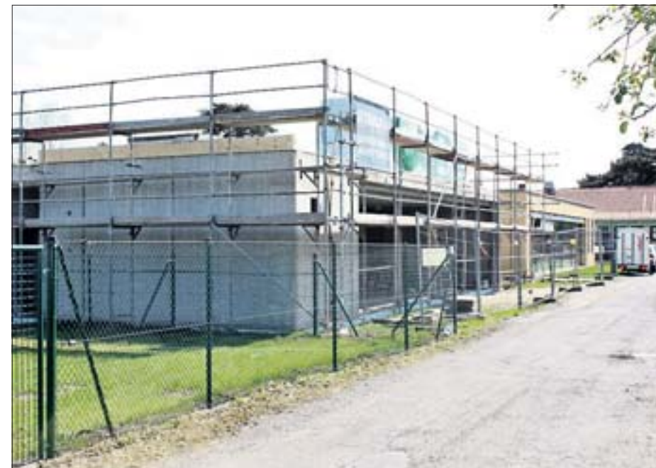
Froh über den Rohbau: Das Institut für Bodenkunde bekommt mehr Platz.
